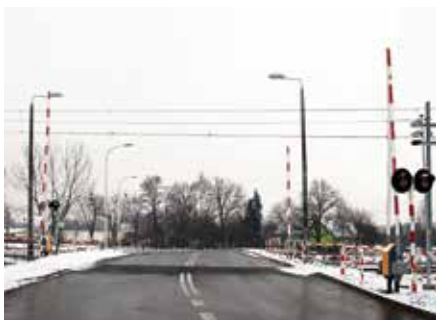
Na początku 2012 roku do użytku została oddana ul. Łączna, która połączyła ze sobą ulice Mała Łąka i Frysztaćka. (fot. BZ)
