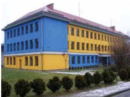
Tak po termomodernizacji prezentuje się Szkoła Podstawowa nr 2... (fot. SP 2)
